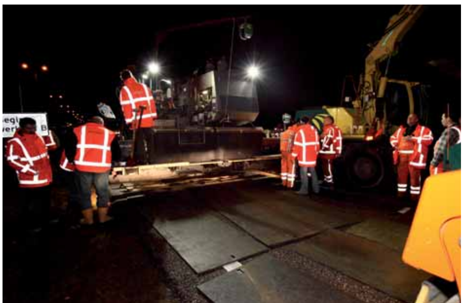
Proef om de mogelijkheden van verwerking ZOAB in de winter heeft extra informatie opgeleverd.
